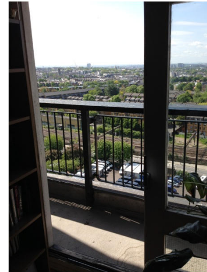
Photo 2 – Sliding balcony door
